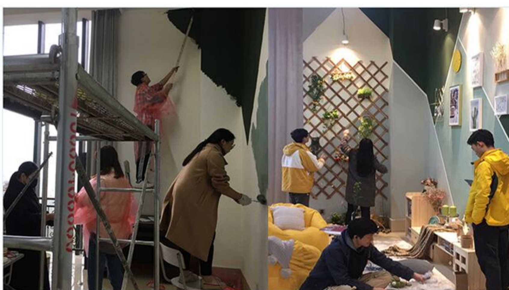
室内空间改造——现场施工、陈列设计
